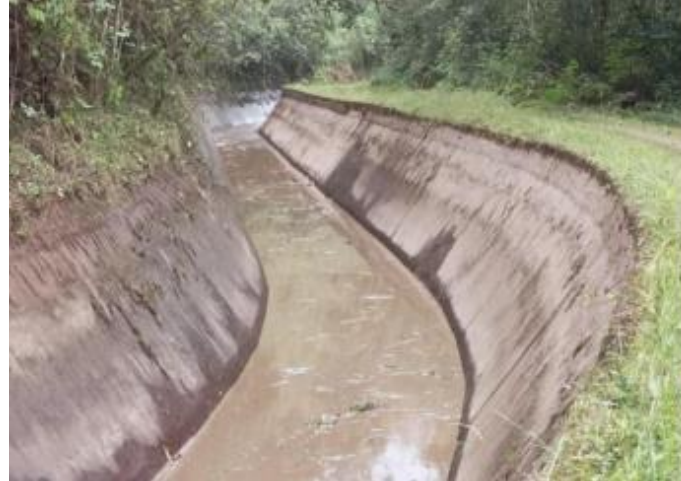
Grafica No. 39: Estado del canal posterior al mantenimiento
