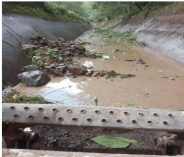
Grafica No. 35: Material y sedimentos en el canal de conducción
