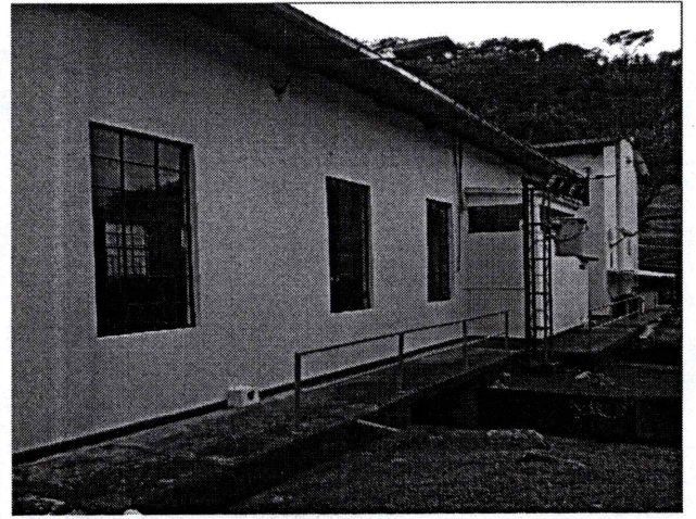
Casa de máquinas PCH Mondomo
