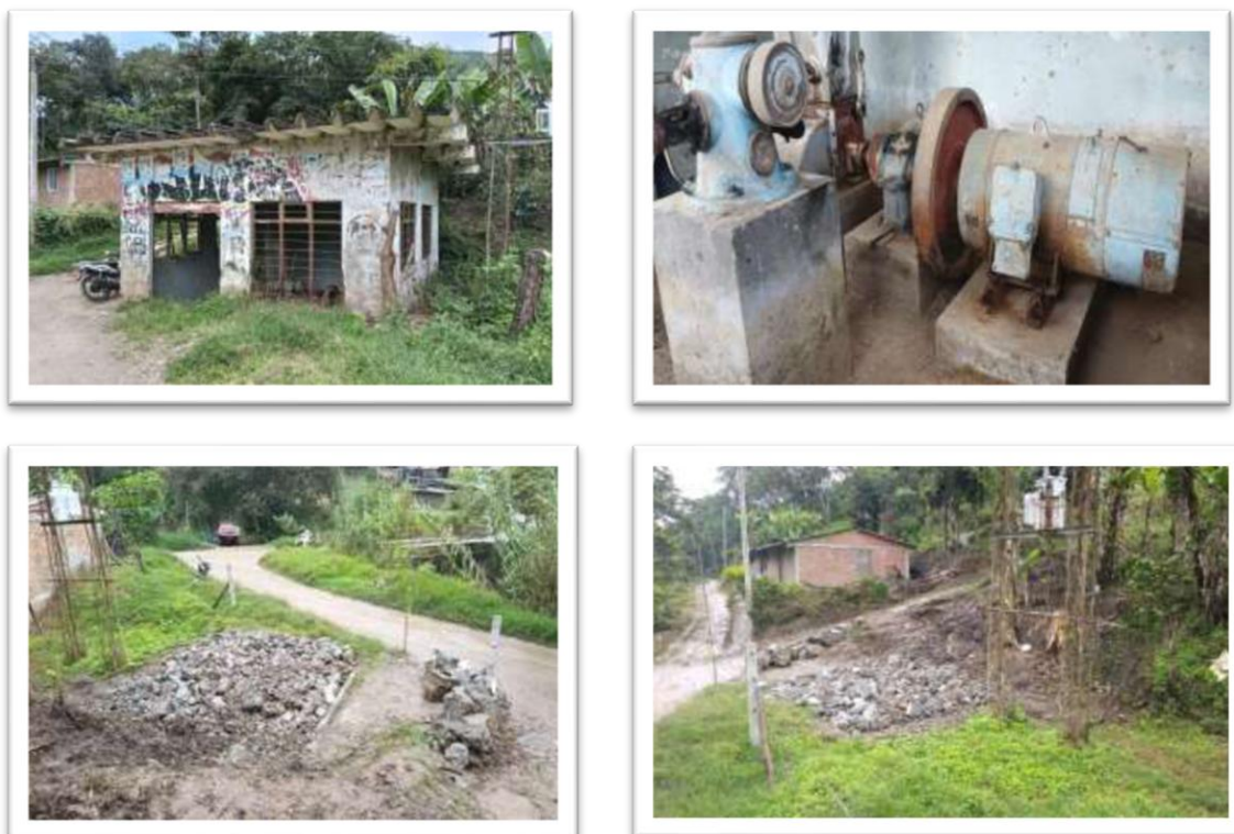
Grafica No. 65: Actividades en terreno desmonte de PCH Toribio CTO. 0073-2025
