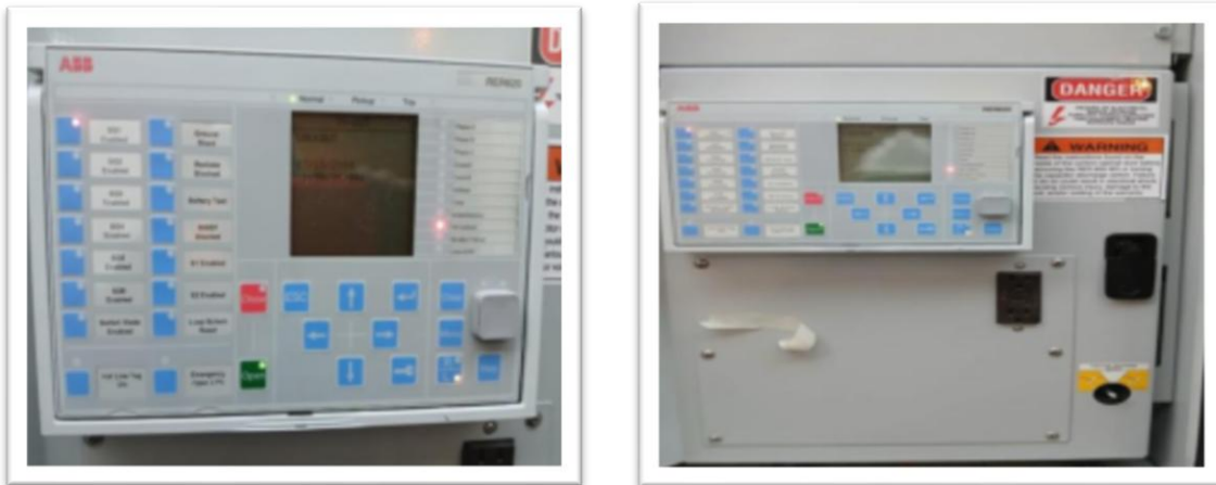
Grafica No. 39: Reposición a nuevo de Reconectador
