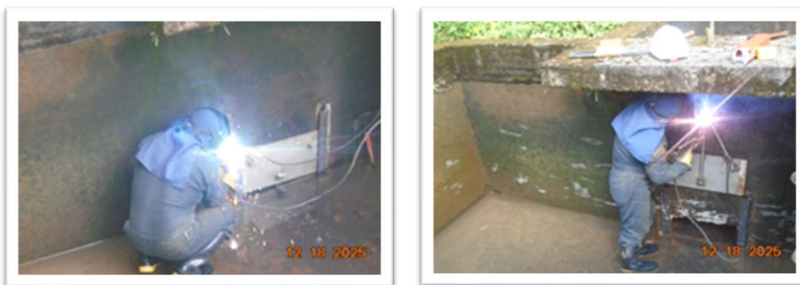
Grafica No. 55: Instalación de compuerta tanque #1 y tanque #2.
