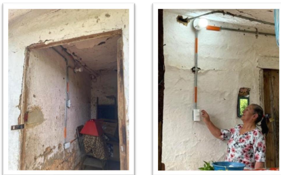
Grafica No. 63: Instalación de redes internas en la vereda Los Alpes de Piendamó
