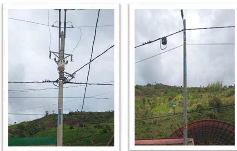
Gráfica No.21: Obras de ejecución de Red segura
