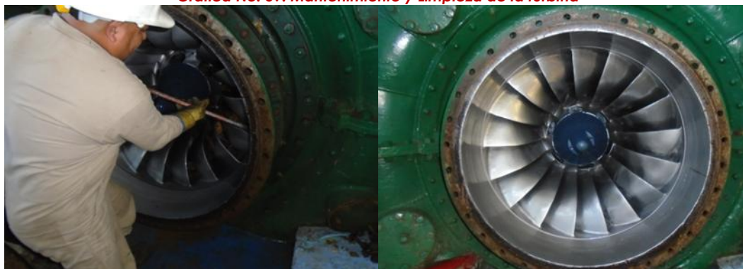
Grafica No. 59: Mantenimiento y Limpieza de la turbina
