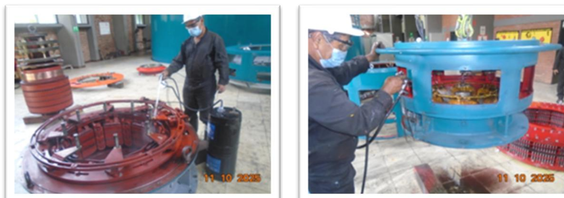
Grafica No. 52: Mantenimiento del sistema de excitación
