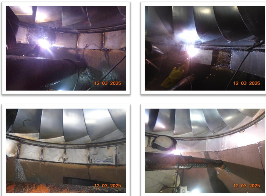
Grafica No. 51: Reposición de platinas en el cono aspirador de Florida II
