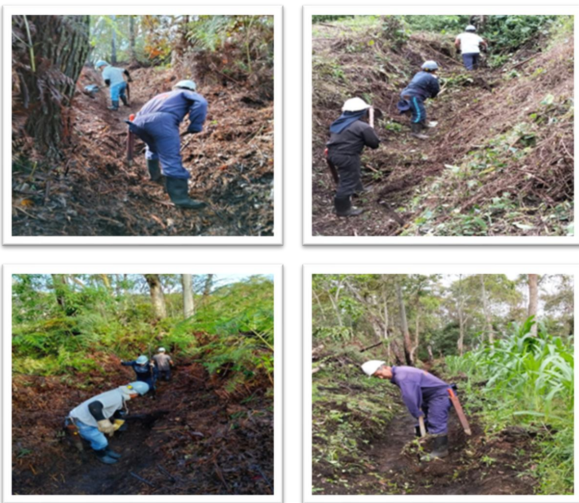
Grafica No. 49: Zanjas de coronación Pantanos, Colorados, Vereda San Isidro y PCH Florida II.
