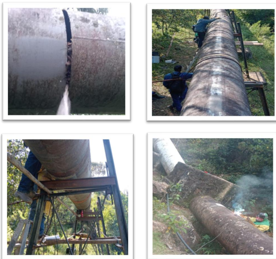
Grafica No. 46: Instalación de nueva tubería de presión y construcción bases de apoyo
