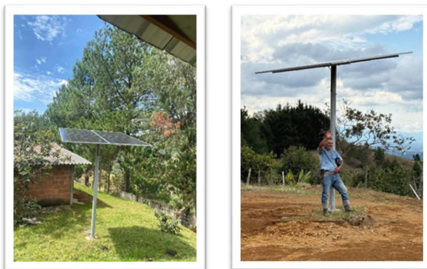
Grafica No.62: Instalación de SSFVI en la vereda Los Alpes de Piendamó
