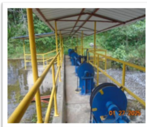
Gráfica No. 36: Mantenimiento a las compuertas de bocatoma y Vinagre
