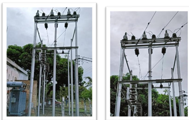
Grafica No. 42: Reposición de transformadores potencial y medidores de frontera en PCH RIO PALO
