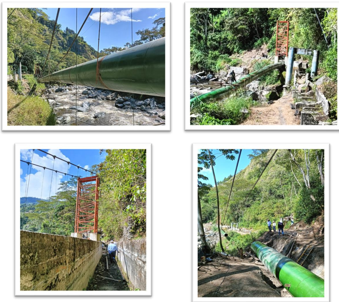
Grafica No. 45: Construcción de torrecillas y bases de concreto para apoyo de cables.
