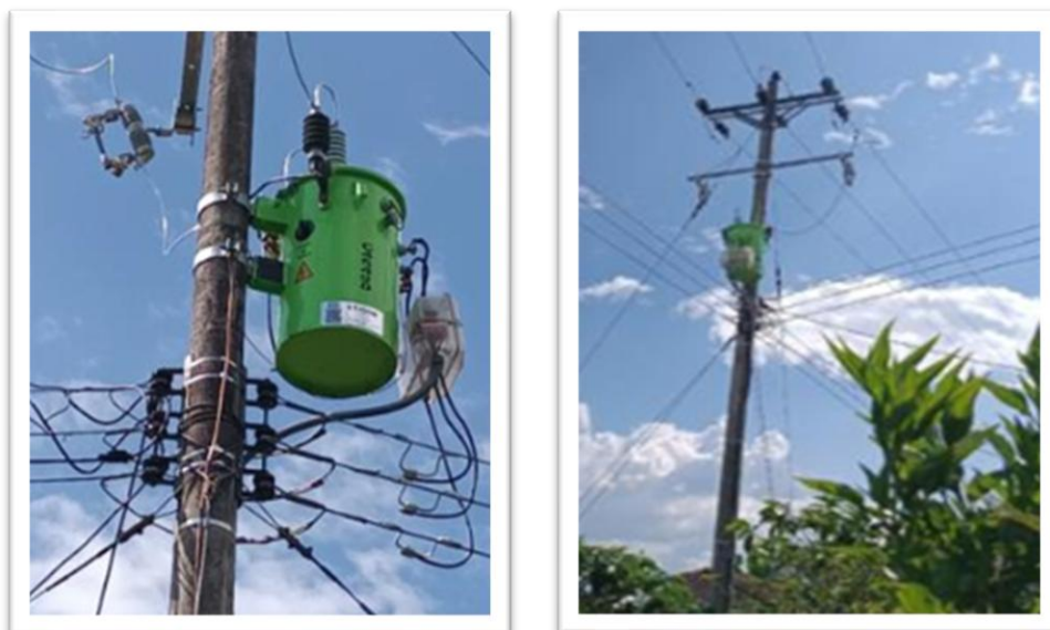
Gráfica No.20: Reposición de transformadores
