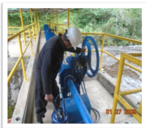
Gráfica No. 36: Mantenimiento a las compuertas de bocatoma y Vinagre
