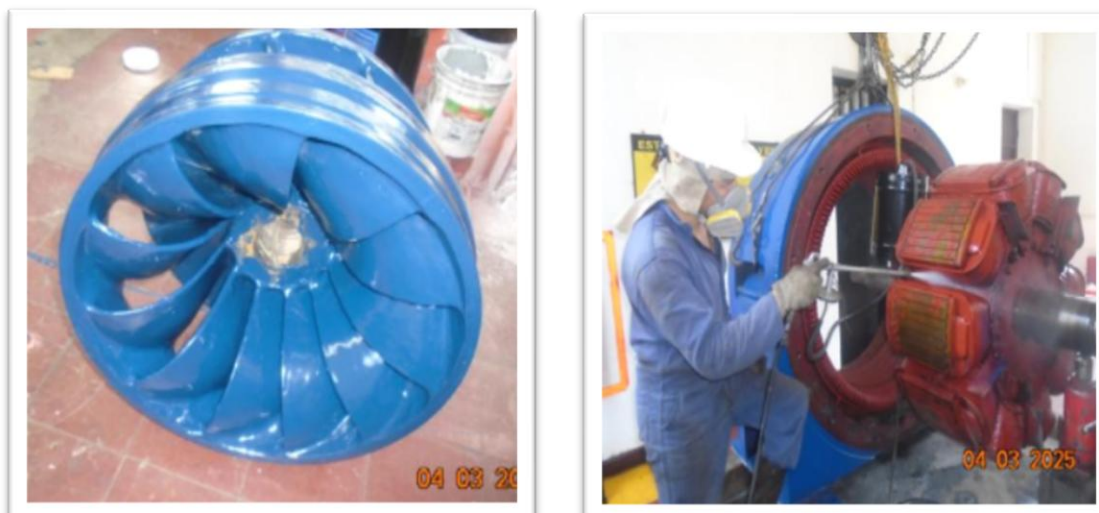
Grafica No. 47: Mantenimiento de turbina, limpieza de generador, cojinete y estator.
