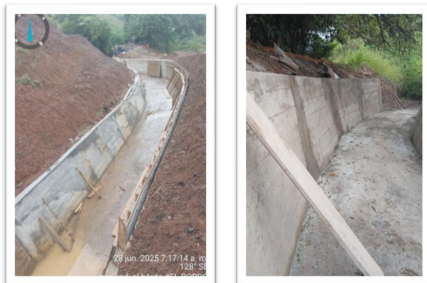
Grafica No. 38: Reparación de canal de conducción y estabilización del talud en PCH SAJANDI
