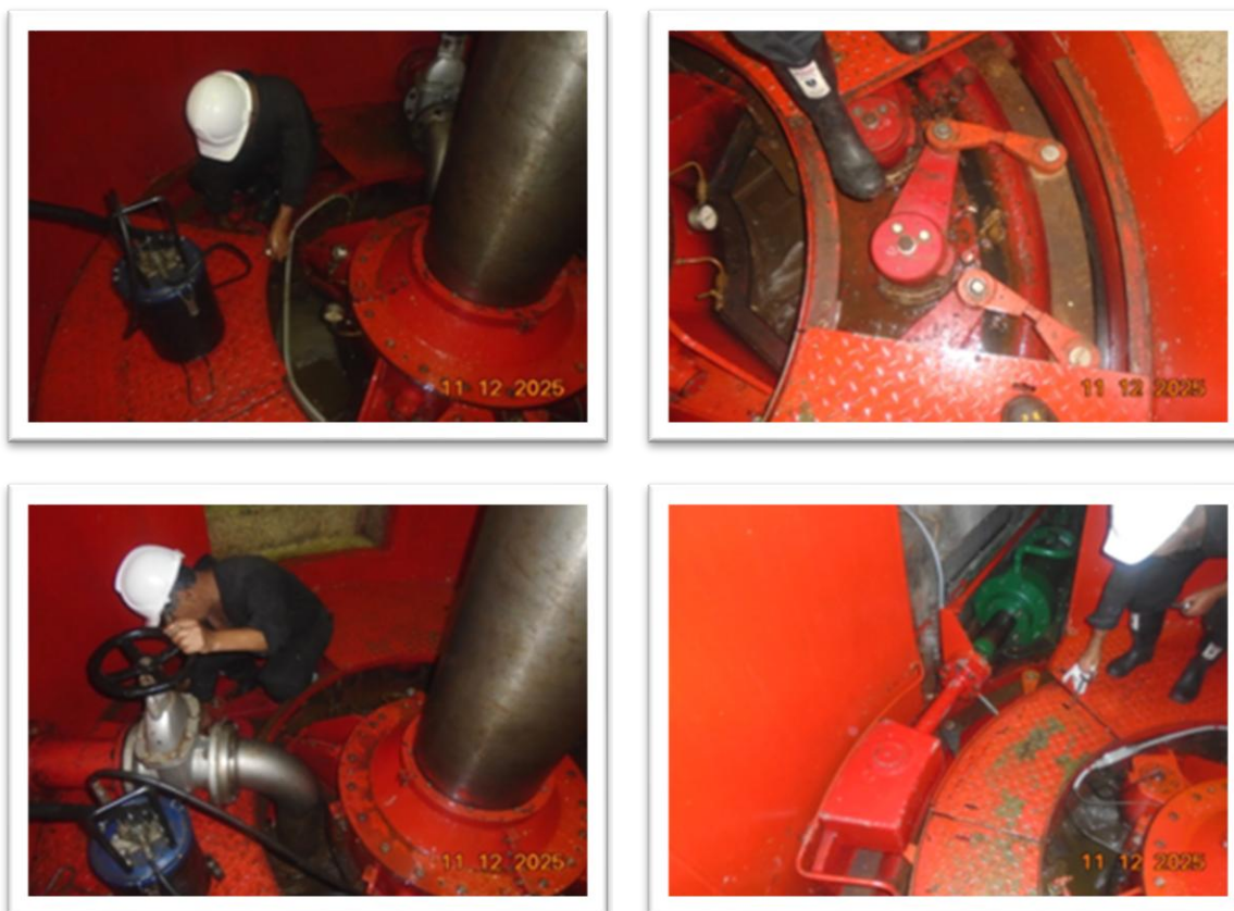
Grafica No. 57: Mantenimiento turbina G1 y G2
