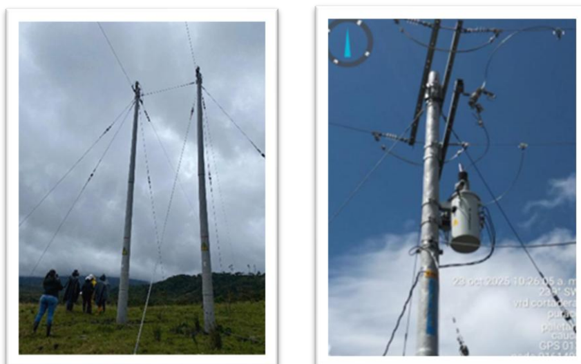
Grafica No. 70: Redes de MT/BT y Centros de transformación. Paletará – Puracé.
