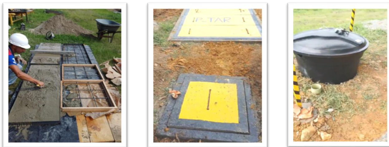
Grafica No. 37: Construcción sistema tratamiento de aguas residuales en la PCH FLORIDA II
