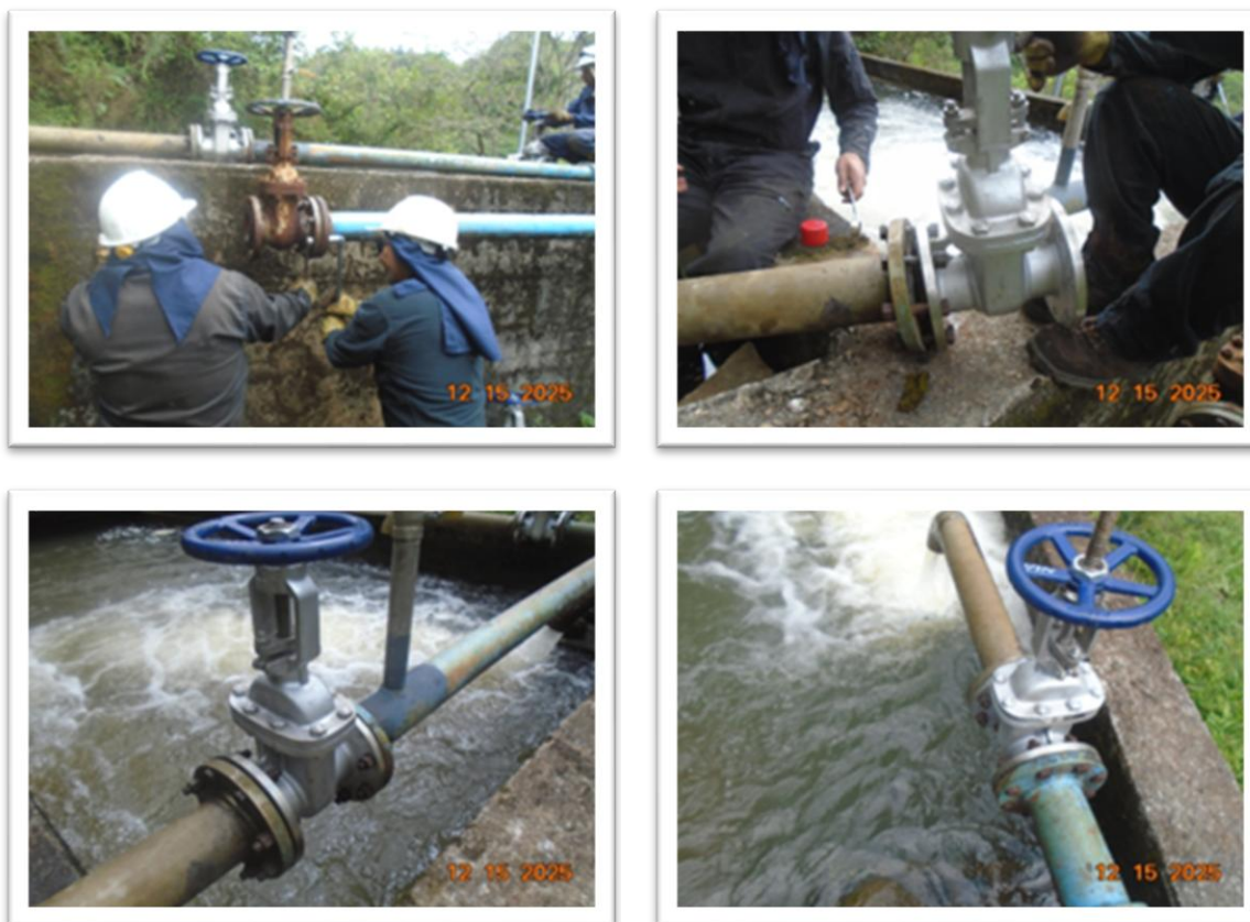
Grafica No. 54: Instalación válvulas
