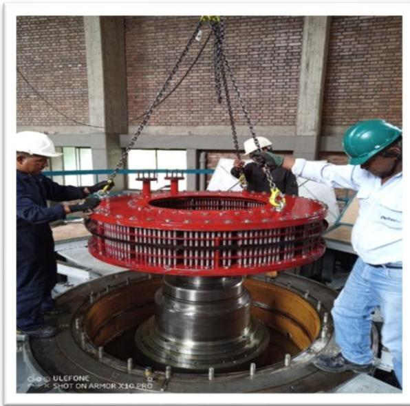
**Retiro del intercambiador de calor "serpentin" para cambio por el de repuesto.**
