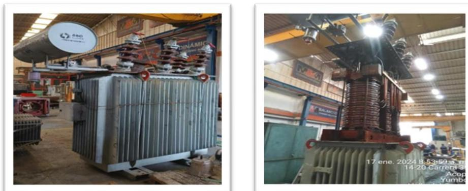
El segundo transformador del grupo G2 de 900 KVA 33/.044 KV, fue reparado en su aislamiento con un costo de mantenimiento correctivo por \$107.374.890.
